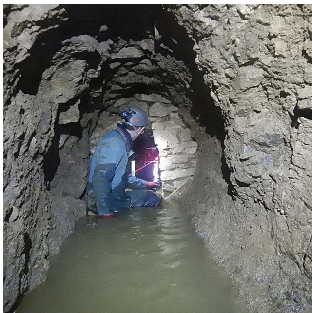
Aqueduc souterrain d'alimentation en eau (Condat-sur-Vienne, Haute-Vienne)
