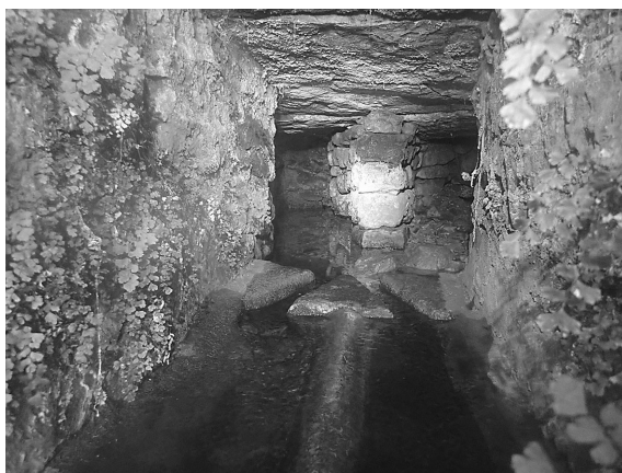
Fig. 5. La galerie d'entrée du captage avec deux chenaux parallèles reliés à un répartiteur de volumes, mène au fond à deux galeries de captage de part et d'autre d'un pilastre central. Noter les fougères en premier plan : des capillaires de Montpellier. Cliché François Lefebvre.
