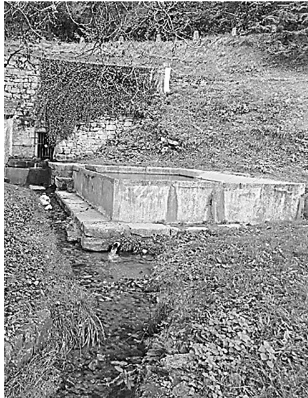
Fig. 3. Le site du Cluzel. Le lavoir en bas reçoit son eau de la source captée (ouverture rectangulaire noire). Le bâtiment à gauche permet de monter une partie de l'eau vers le château du Puy. Deux routes surmontent le tout et la grotte se trouve au-delà, au niveau de la masse noire au dernier plan.
